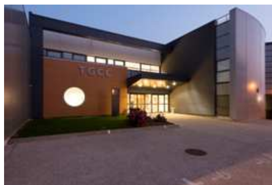
Le Très grand centre de calcul du CEA installé à Bruyères-le-Châtel qui abrite les supercalculateurs Curie et Joliot-Curie ©P. Stroppa/CEA
